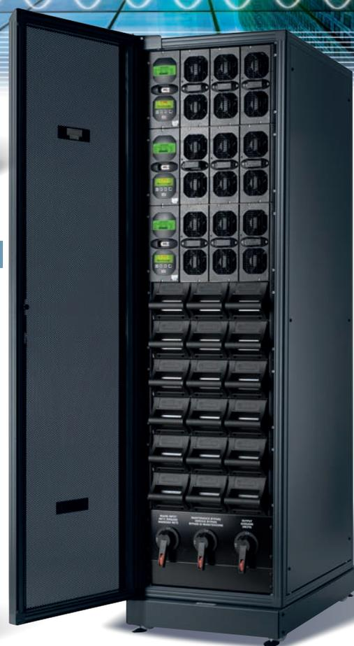
ON-LINE ИБП С ДВОЙНЫМ ПРЕОБРАЗОВАНИЕМ
